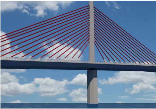
Fig. 10: Detalle del aspecto final de la unión pilono-tablero-pila.
